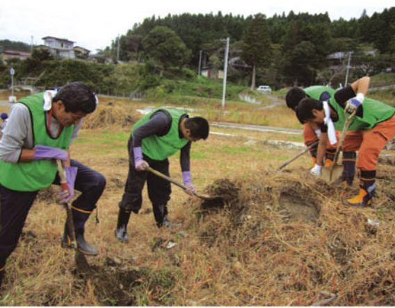
土砂撤去も力仕事だ
